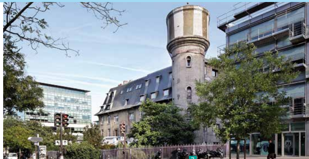
7 LES FRIGOS - ATELIERS D'ARTISTES Construction : 1921 par la Compagnie Ferroviaire de Paris-Orléans
