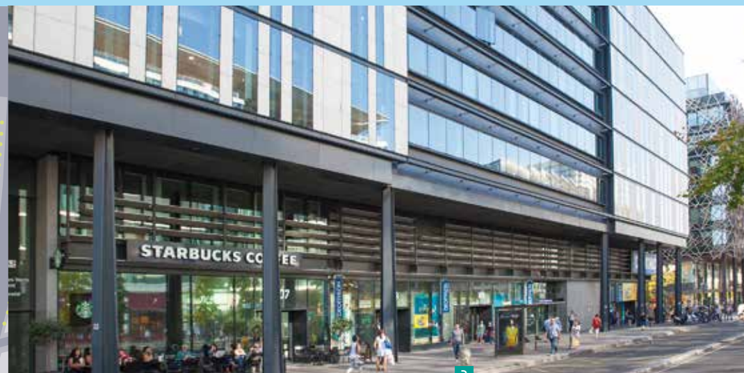
2 93-109, AVENUE DE FRANCE Bureaux / 51 900 m 2 Construction : 2003 Architecte : Jean-Paul Viguier Promoteur : SARIS Laboratoire Merck, Mairie de Paris, Ministère des Sports et de la Jeunesse, URSSAF
