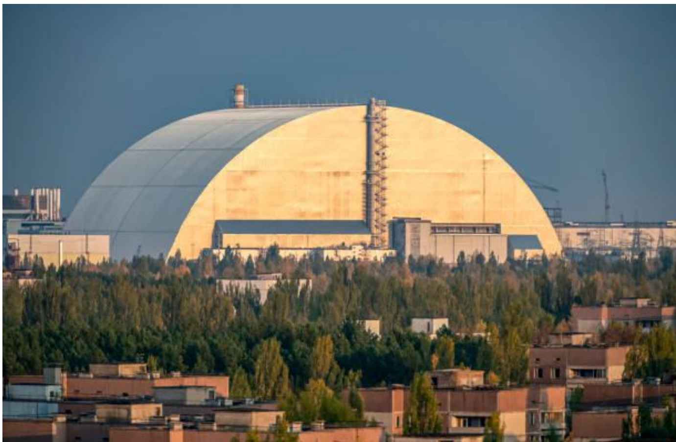
La centrale de Tchernobyl coiffée d'un sarcophage en béton depuis 2016 pour éviter tout sur-accident.
